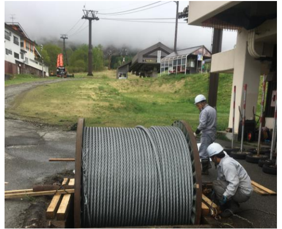
梅池ゴンドラ1区支えい索交換工事
